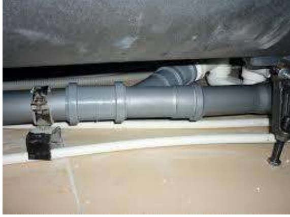
Görsel 5.20: PVC boru yatay birleştirme
