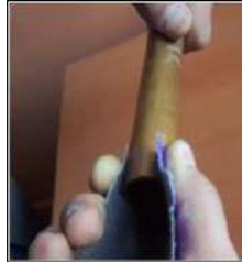
Görsel 6.11: Bakır borunun zımpara ile temizlenmesi
