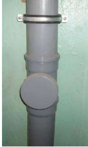
Görsel 5.21: PVC boru dikey birleştirme
