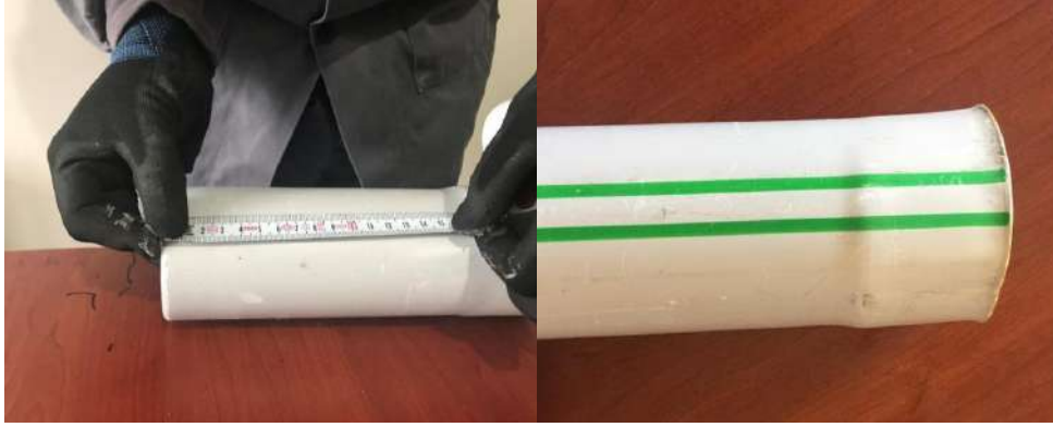
Görsel 5.24 Muf açılmış boruyu birleştirme aşamaları
