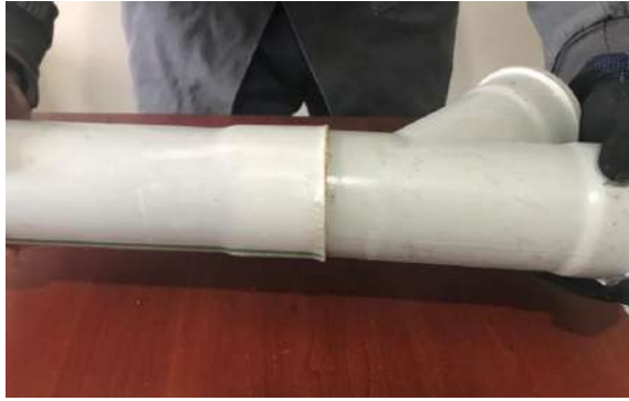
Görsel 5.23: Muf açılmış boruyu birleştirme
