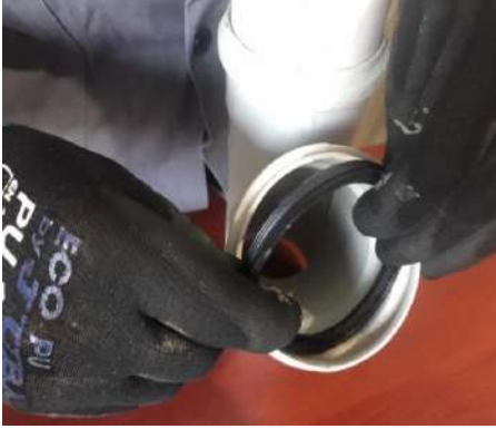
Görsel 5.19: PVC boru conta takılması
