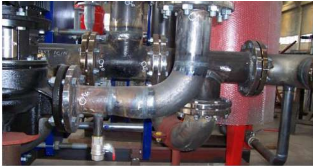
Görsel 12.20:Flanşla birleştirilmiş boru donanımı
