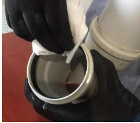
Görsel 5.19: PVC boru conta takılması
